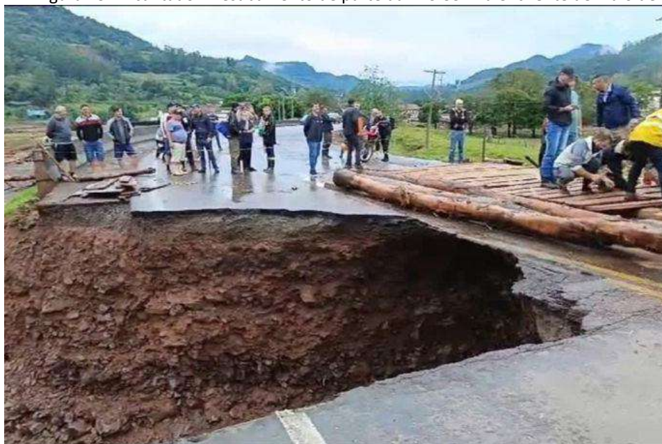
Figura 23: Encantado - Desabamento de parte da ERS-332 na enchente de maio de 2024.
