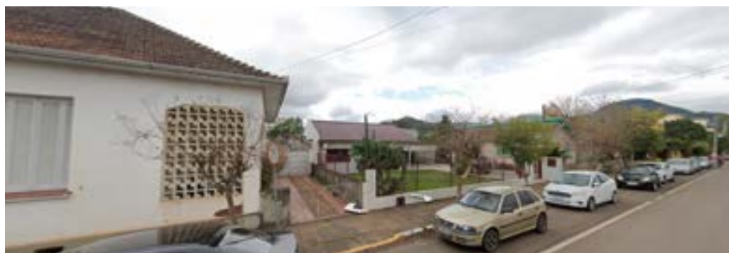
Figura 188: Quadra 1 - Vista da rua Trinta e Um de Março.
