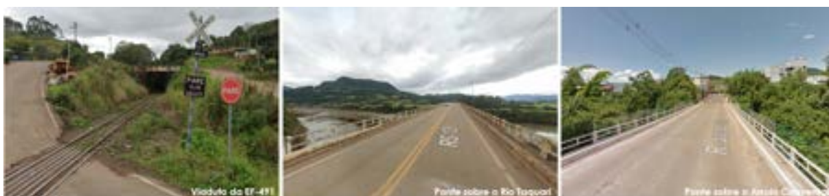
Figura 279: Viaduto da EF-491 e pontes sobre o Rio Taquari e Arroio Conventos, do município de Roca Sales.
