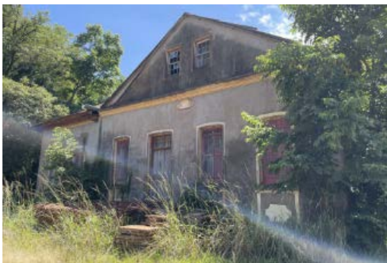
Figura 147: Casarão Comercial e Salão de Bailes do município de Roca Sales.
