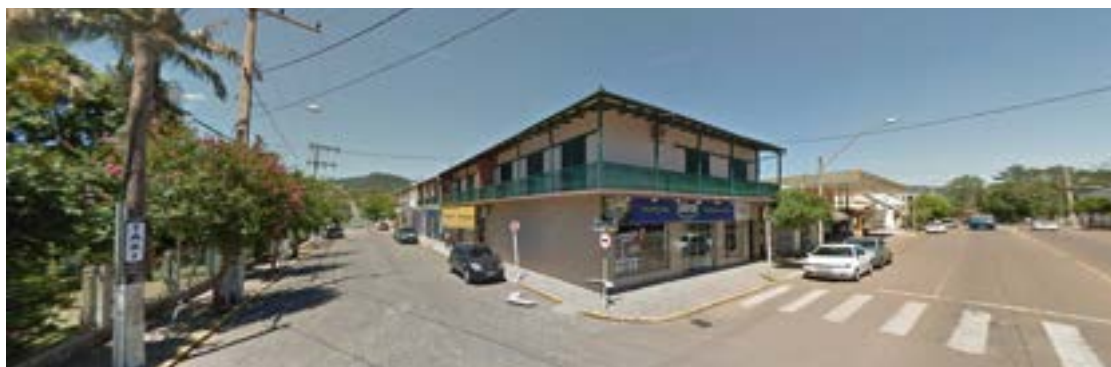
Figura 186: Quadra 1 - Vista da Avenida General Daltro Filho, esquina com a Rua Emílio Langer.
