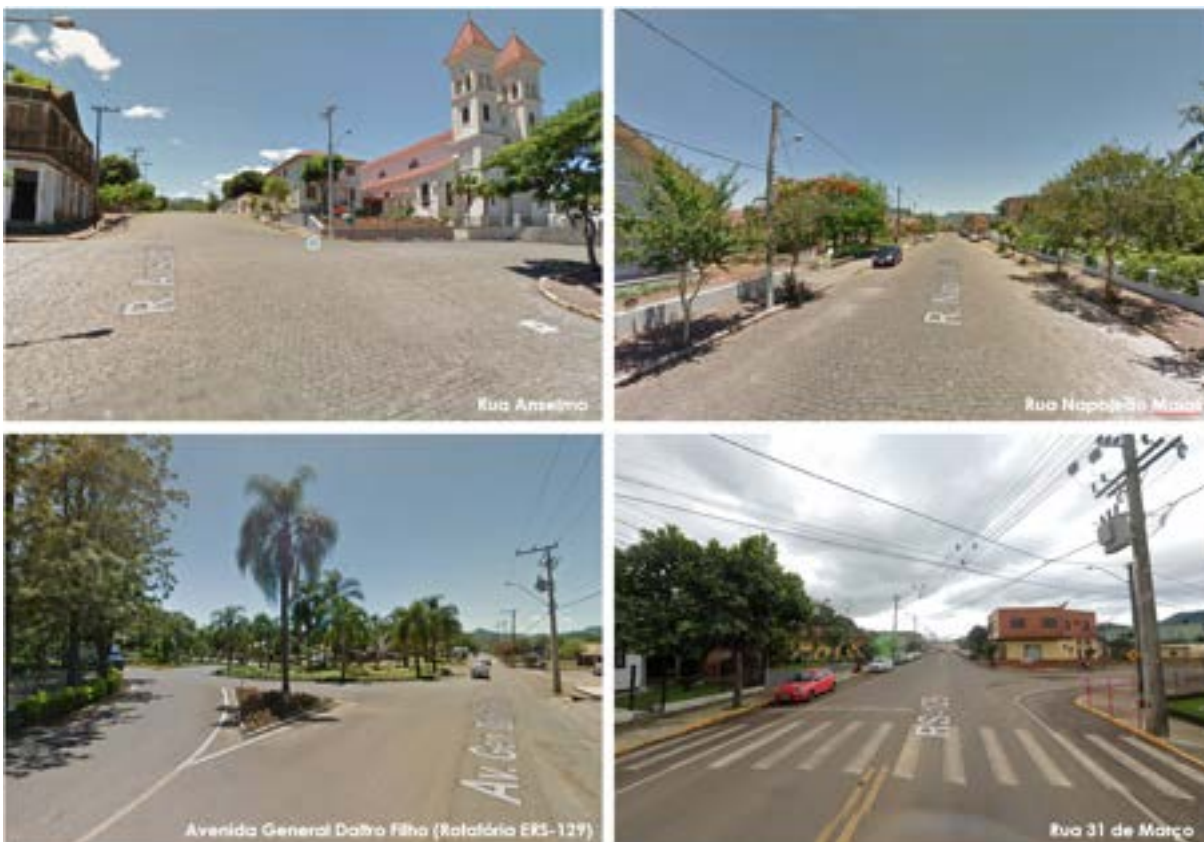
Figura 278: Pavimentação de ruas do município de Roca Sales- sede.
