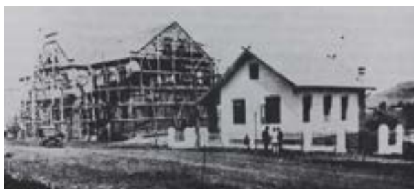
Figura 126: Construção da Casa de Saúde em 1926, na Rua General Osório, nº 70.
