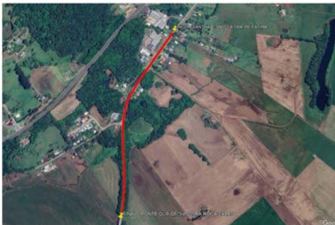
Figura 287: Ampliação da ciclovia do Lajeadozinho até a ponte entre Encantado e Roca Sales.
